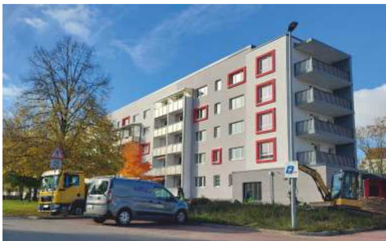
Giebel Otto-Dix-Straße 2 mit Balkonen
