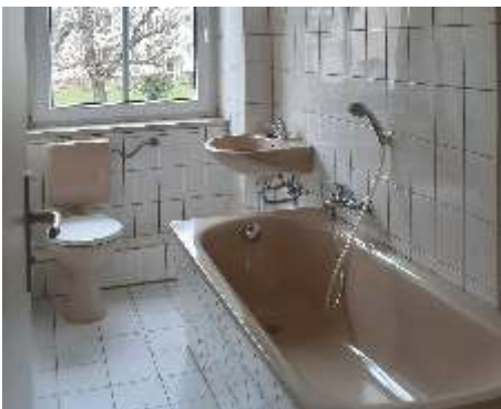
Badsanierung 90er Jahre, Brockhausstraße 24 und 26
