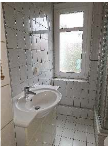
Badsanierung 90er Jahre, Sternstraße 3
